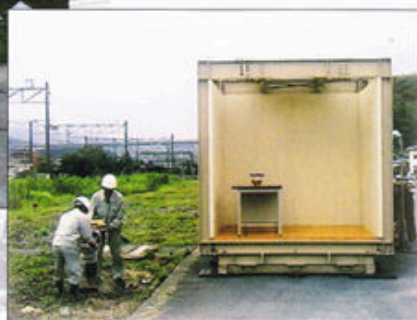
■工事振動測定風景
